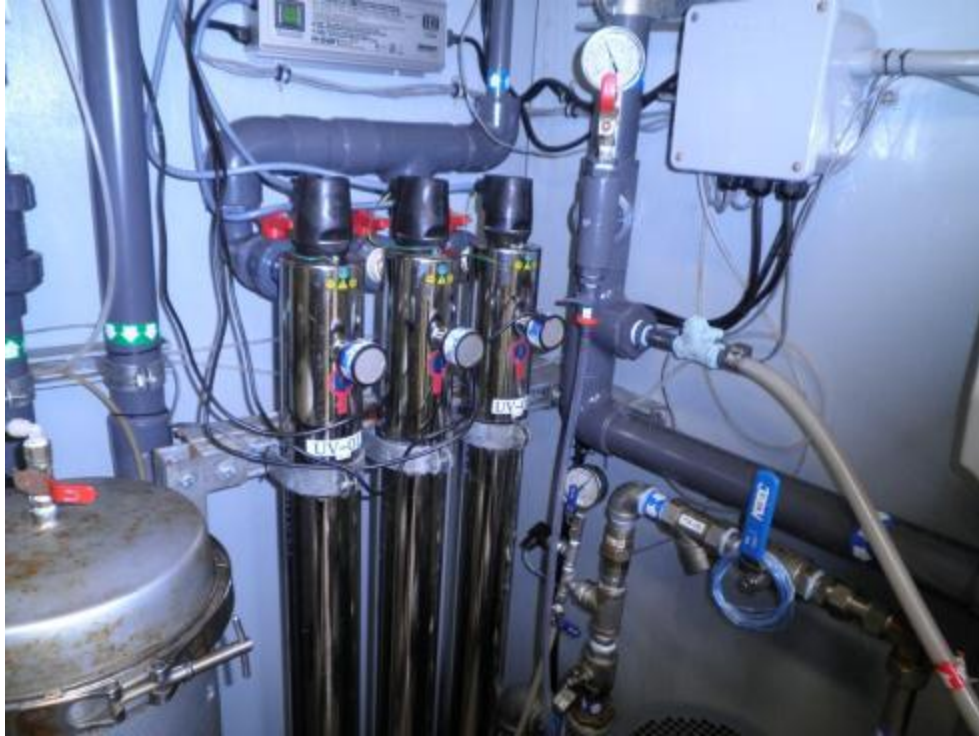
UV filtration apparatus
